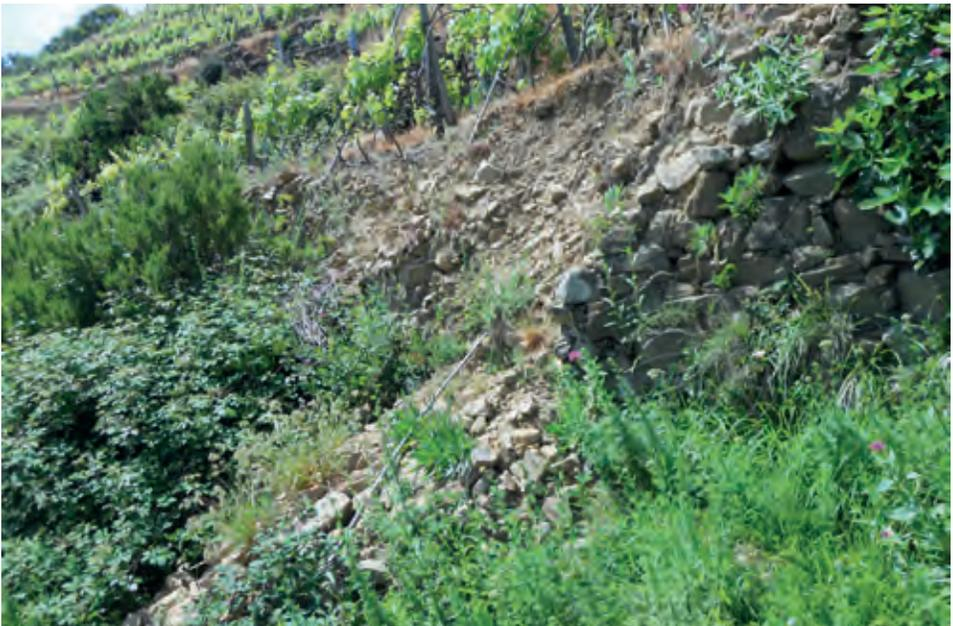
*Fig. 6 - Particolare di un recente fenomeno di crollo di un muro in pietra a secco in arenaria di contenimento di una terrazza coltivata a vigneto (Foto P. Brandolini).*
